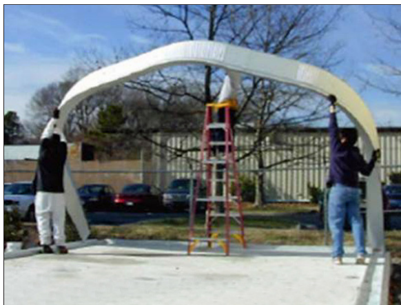
Paso 3: Poner el arco en posición vertical
