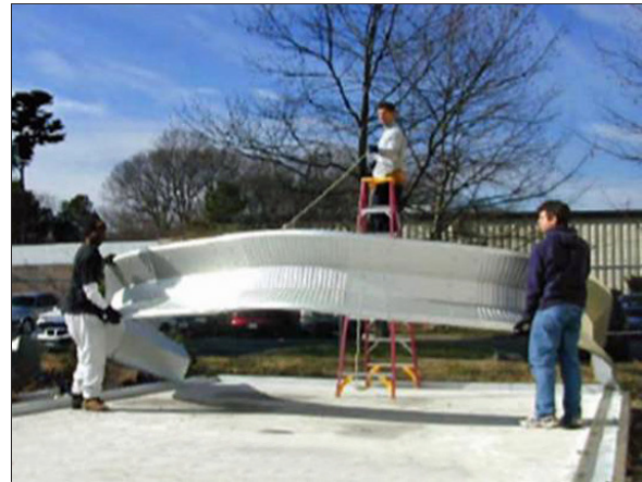
Paso 2: Levantar el arco con la cuerda
