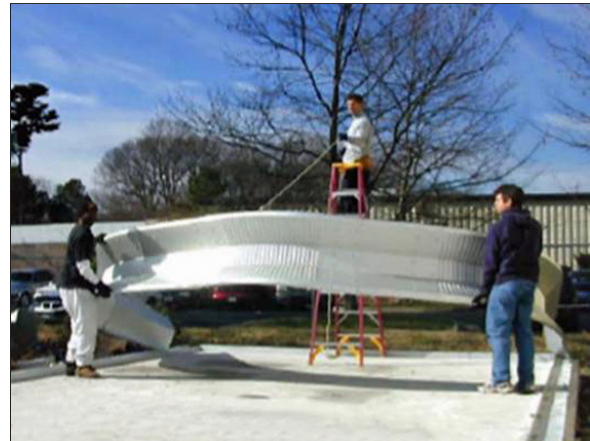
Paso 2: Levantar el arco con la cuerda
