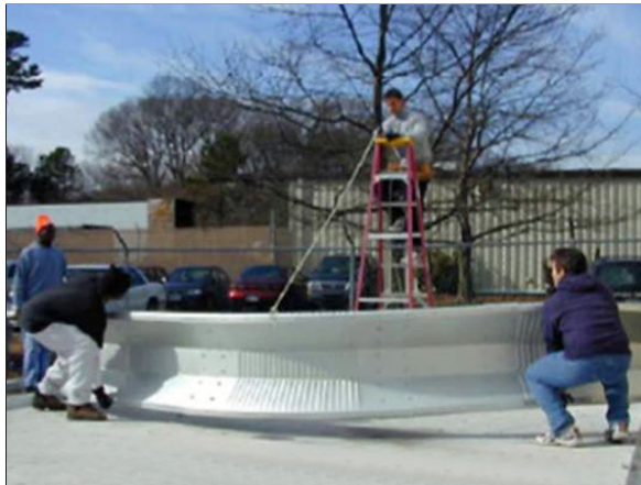
Paso 1: Construir el arco en el suelo
