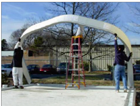
Paso 3: Poner el arco en posición vertical
