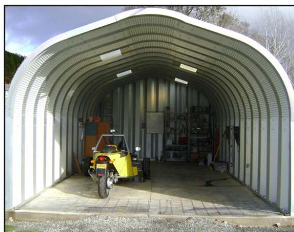
Paso 6: Completar la estructura
