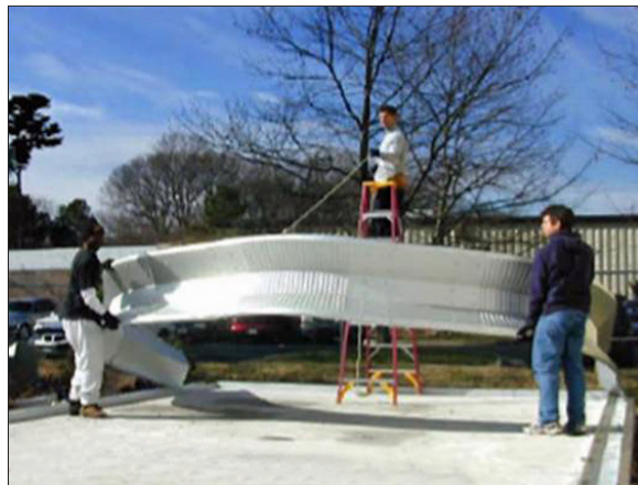
Paso 2: Levantar el arco con la cuerda
