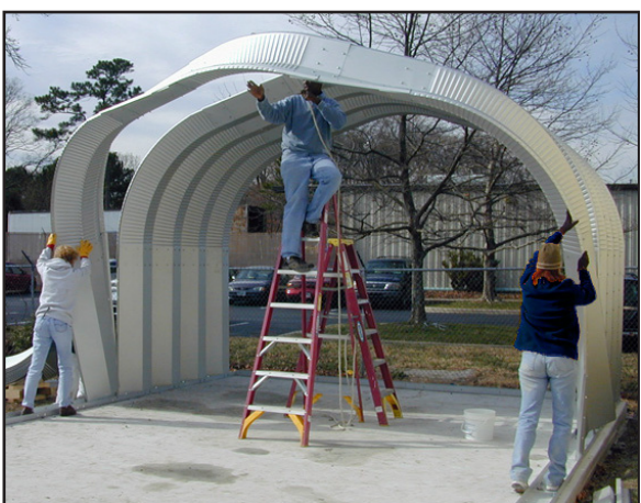
Paso 5: Levantar los siguientes arcos
