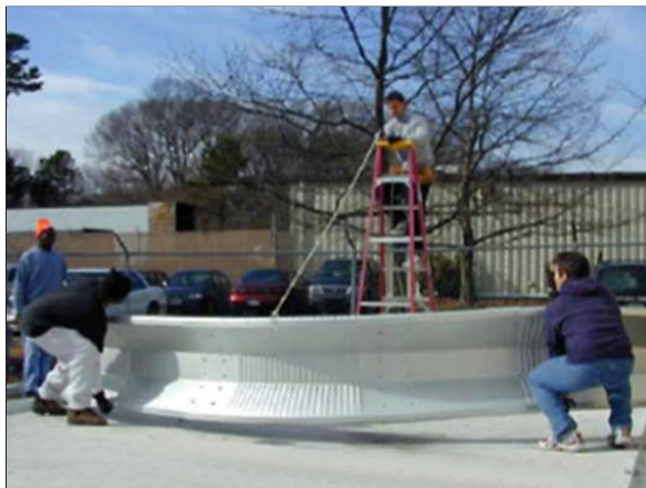
Paso 1: Construir el arco en el suelo
