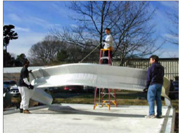
Paso 2: Levantar el arco con la cuerda
