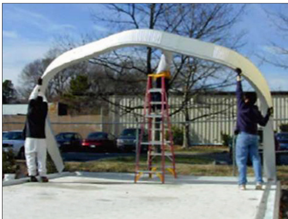
Paso 3: Poner el arco en posición vertical
