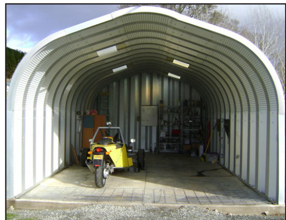
Paso 6: Completar la estructura
