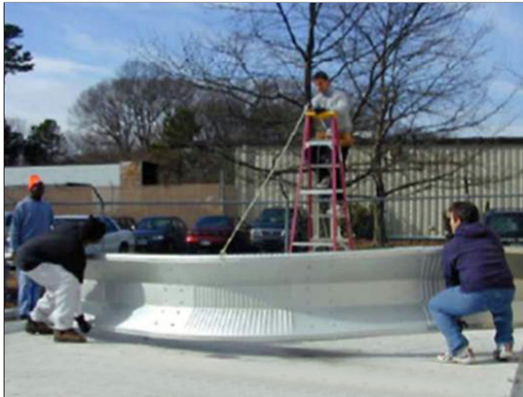
Paso 1: Construir el arco en el suelo
