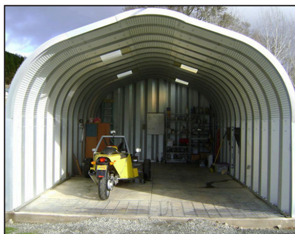
Paso 6: Completar la estructura
