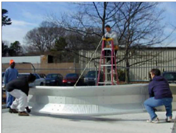
Paso 1: Construir el arco en el suelo
