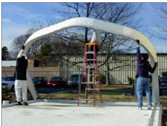
Paso 3: Poner el arco en posición vertical
