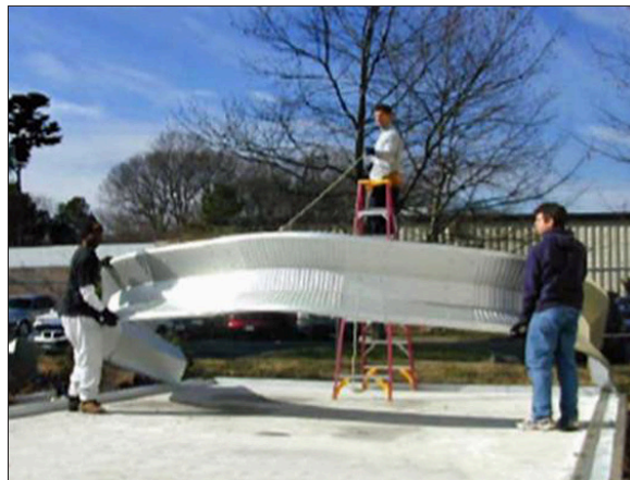
Paso 2: Levantar el arco con la cuerda
