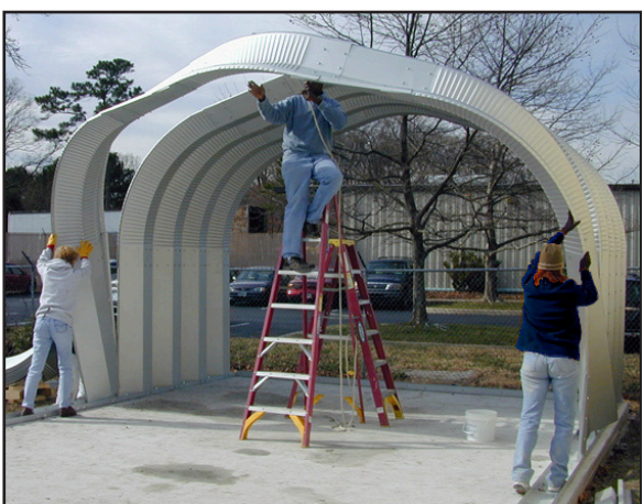
Paso 5: Levantar los siguientes arcos
