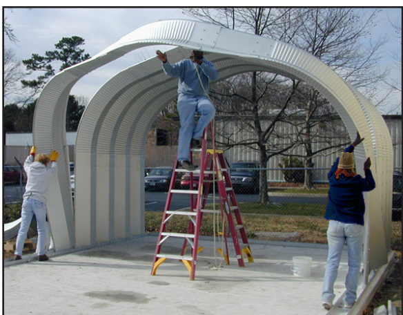
Paso 5: Levantar los siguientes arcos
