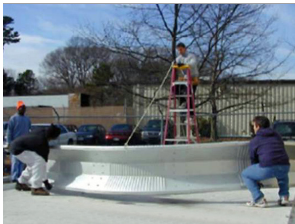
Paso 1: Construir el arco en el suelo
