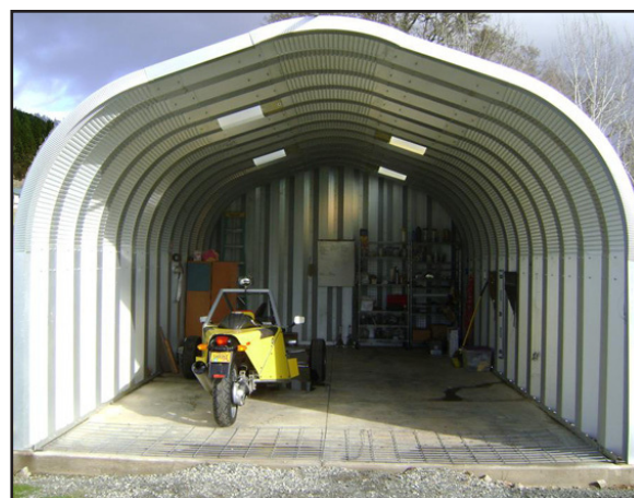
Paso 6: Completar la estructura
