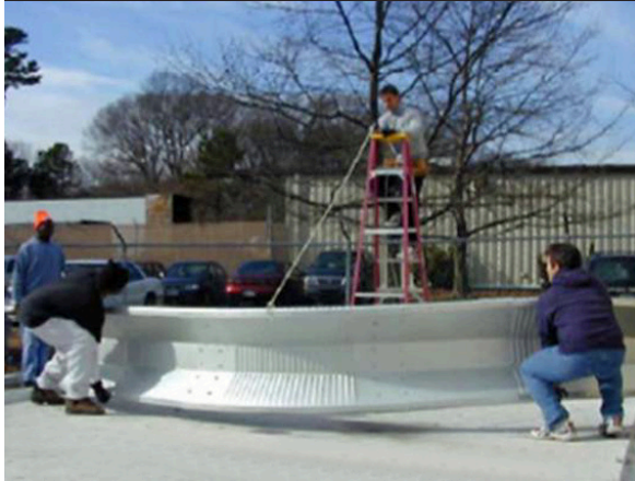
Paso 1: Construir el arco en el suelo
