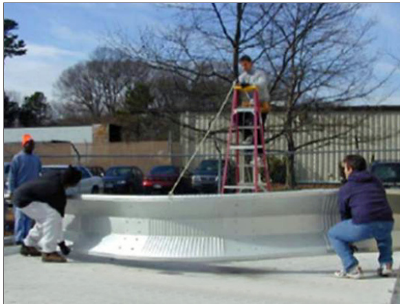
Paso 1: Construir el arco en el suelo
