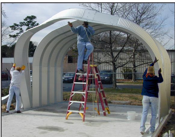
Paso 5: Levantar los siguientes arcos
