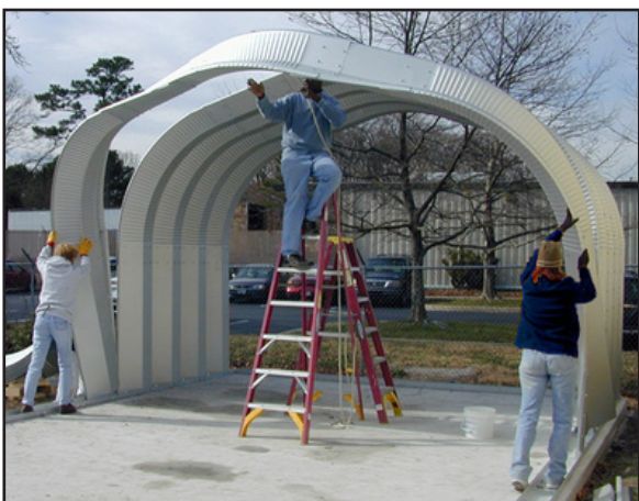
Paso 5: Levantar los siguientes arcos
