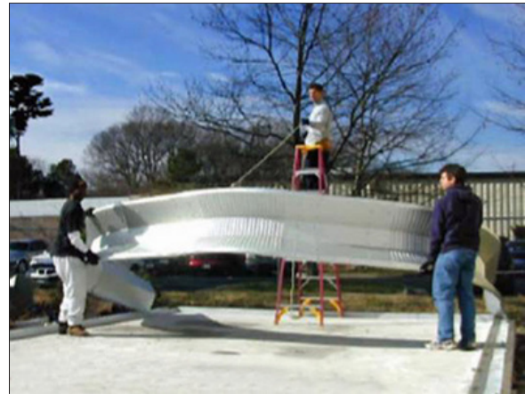
Paso 2: Levantar el arco con la cuerda
