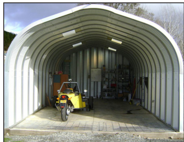
Paso 6: Completar la estructura
