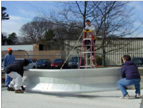
Paso 1: Construir el arco en el suelo
