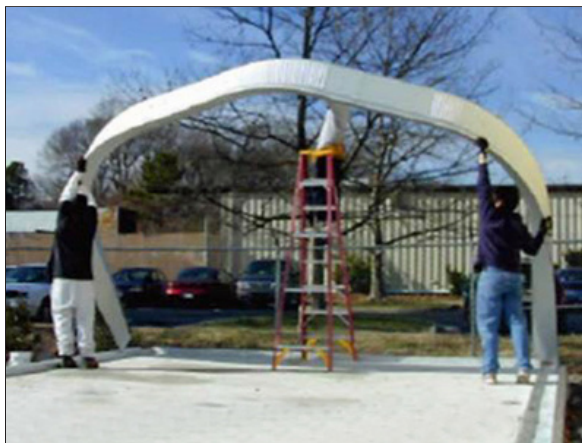
Paso 3: Poner el arco en posición vertical
